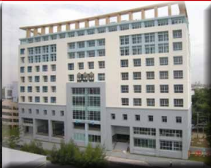
บริหารโครงการก่อสร้าง อาคารเรียนการสอน คณะบริหารธุรกิจ
